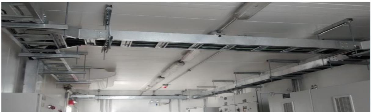
Instalación de bandejas tipo escalerilla para sistema contra incendio en sala de control
