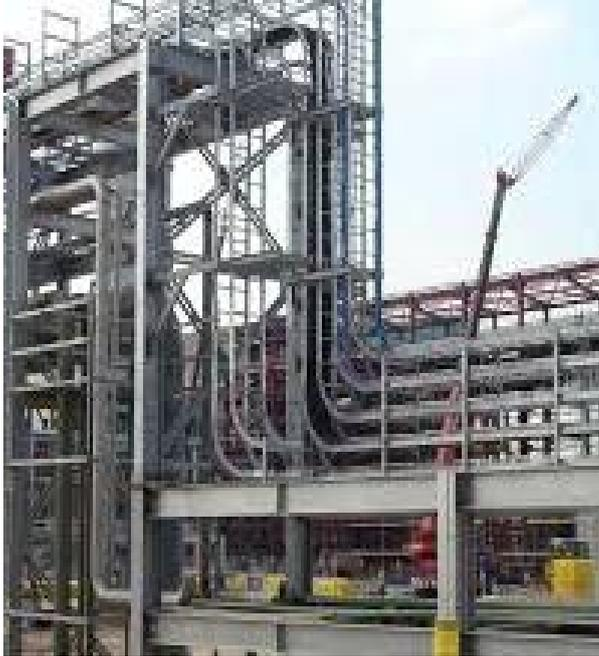
Las bandejas portacables es un tipo de canalización muy eficiente para la conducción de cables eléctricos, son seguras, económicas y de fácil montaje, reduciendo los costos de instalación, favoreciendo el mantenimiento y ampliaciones futuras.
